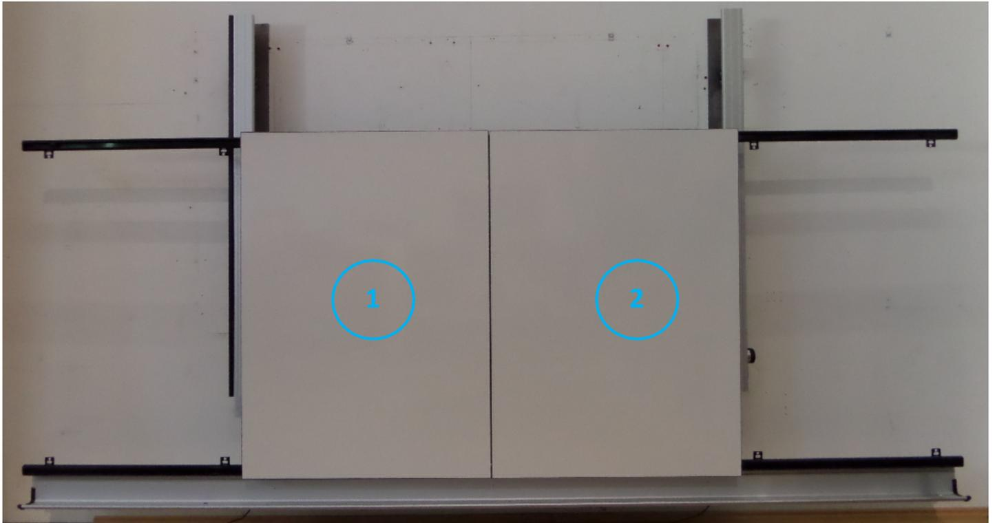
Schiebeflügel (1 + 2) in die Laufschienen einsetzen und ausrichten.
