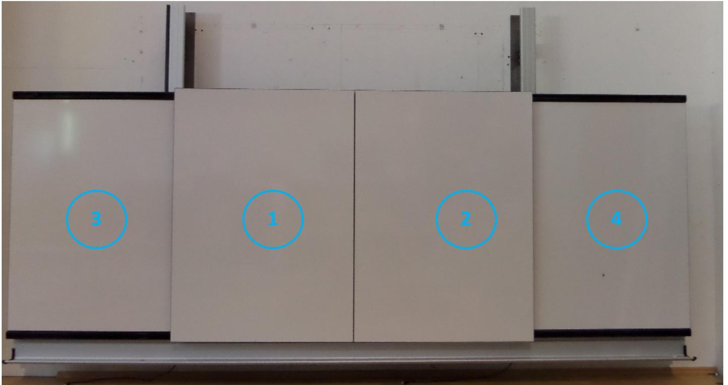
Seitenflügel (3 + 4) einsetzen und mit 4 x Verbindungsplatten und Schrauben M6 x 10 am Rahmen festschrauben.
